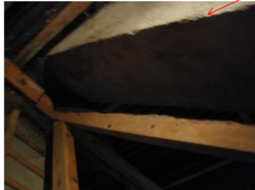
La charpente traditionnelle est déstructurée, impactant sa stabilité. Un entrat a été sectionné.
