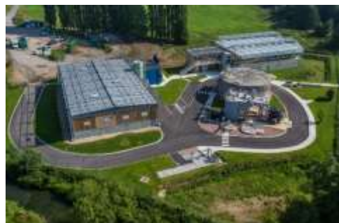
Station d'Épuration de Brionne
