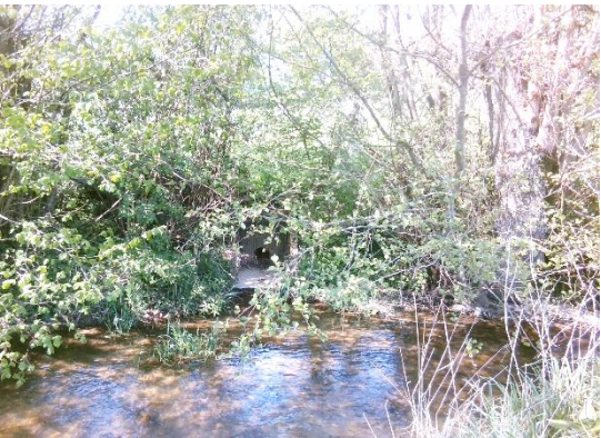
Exutoire de drain
