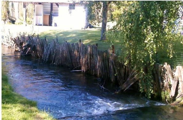
Berge artificialisée avec des pieux en bois
