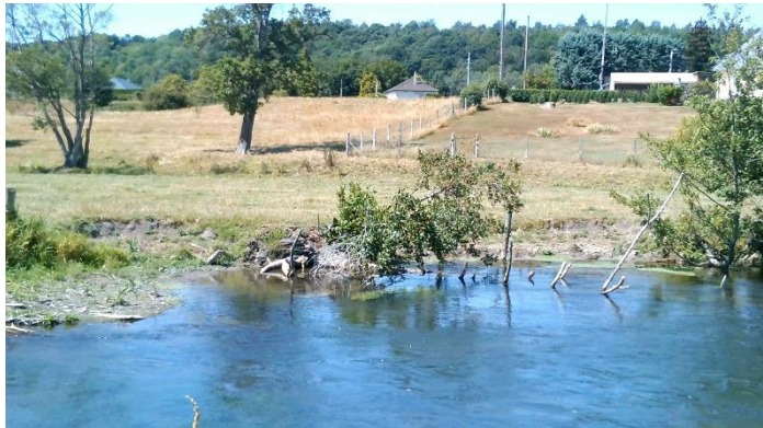
Berge rive gauche piétinée, clôture dans le lit
