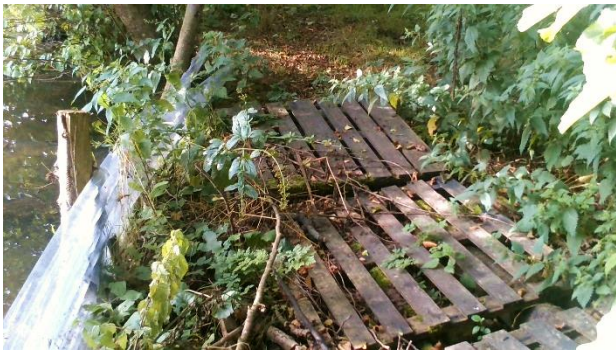
Berge consolidée avec divers matériaux pour assurer un passage
