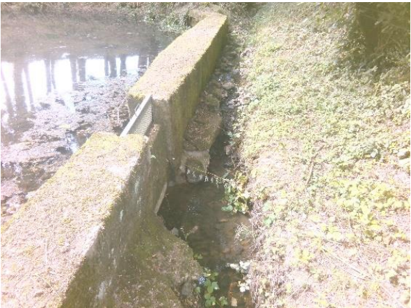
Exutoire d'étang à La Hallière
