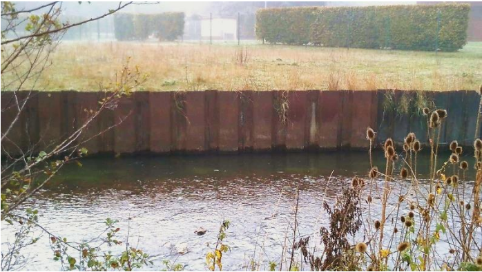
Palplanches à l'aval de Bernay
