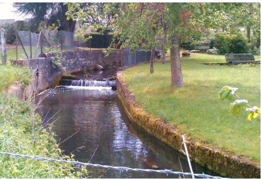
Bras usinier avec seuil
