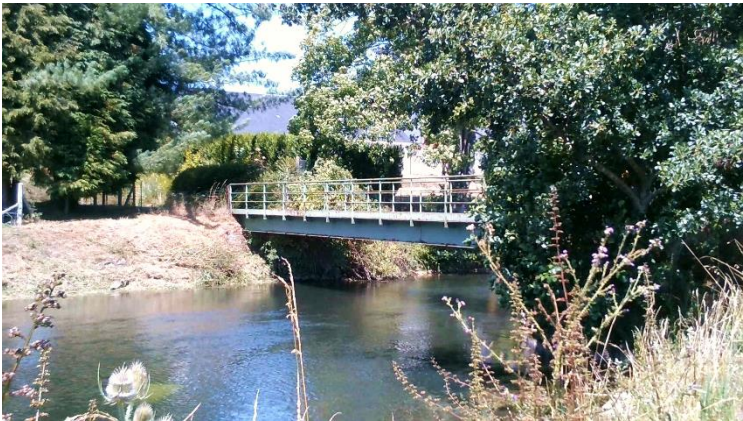
Passerelle située à l'amont de l'ancienne usine Peters Surgical
