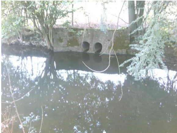
Exutoire de drain
