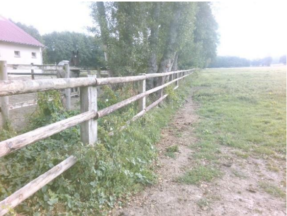
Cours d'eau busé et partiellement perché
