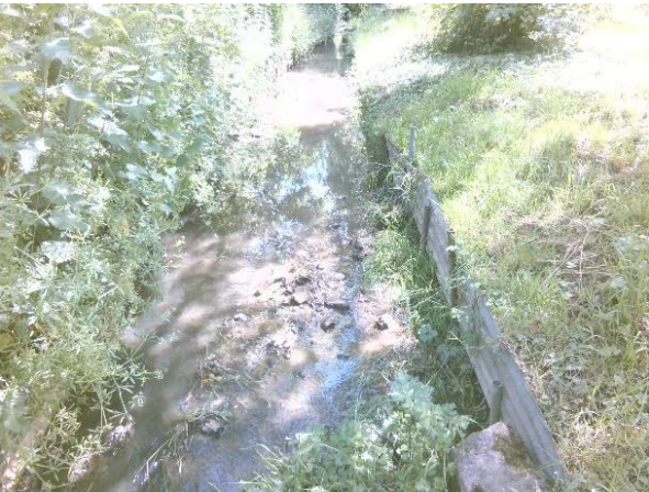
Berge artificialisée (protection de berge inadaptée)
