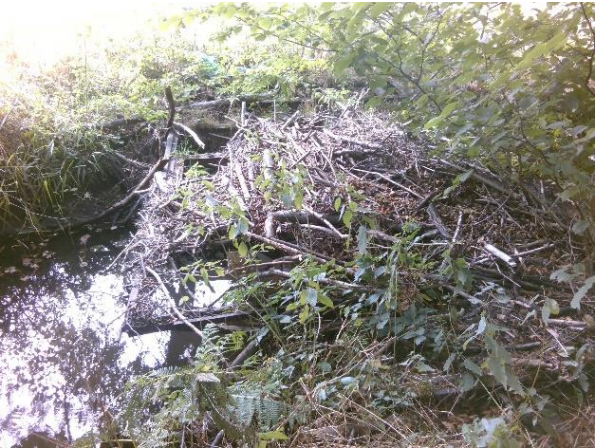
Déchets verts et métalliques dans le cours d'eau
