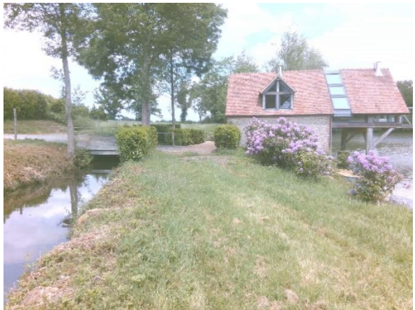
Le cours d'eau, perché et contraint par la présence de merlons, en rive gauche de l'Étang de la Charentonne
