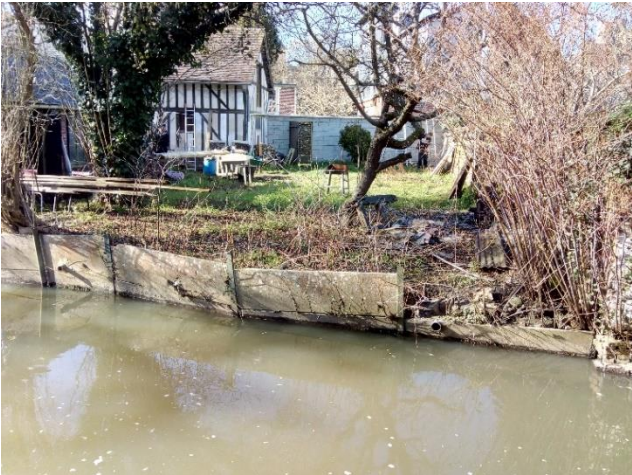
Berge (rive gauche) artificialisée et foyer de Renouée du Japon
