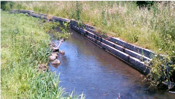
Berge maintenue avec des poteaux électriques
