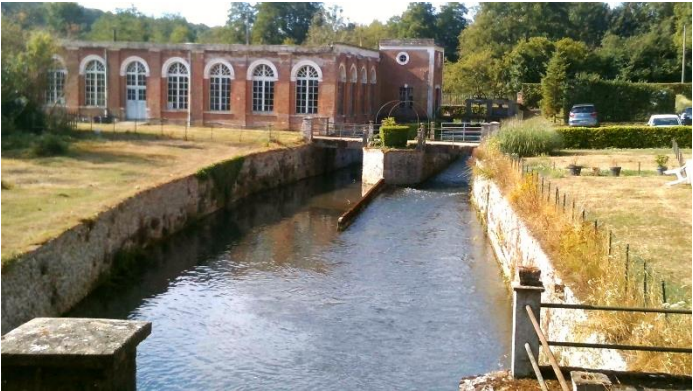
Complexe d’ouvrages hydrauliques situé à l’amont (canal usinier)
