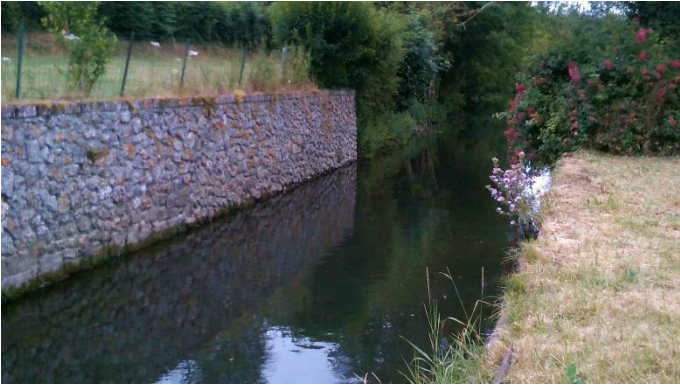
Bras usinier, mur maçonné
