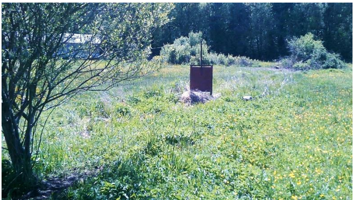
Ancienne petite vanne utilisée pour le baignage des prairies
