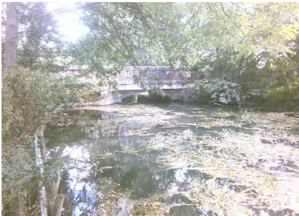
Bief du Moulin d’Anceins et pont sur la D252
