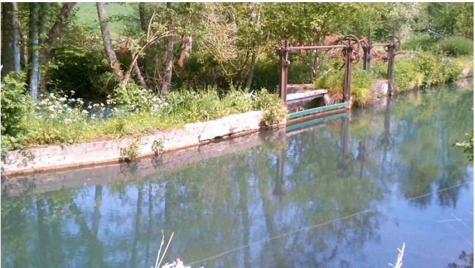
Bras usinier avec ouvrage hydraulique de décharge
