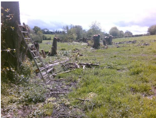
Entretien de ripisylve en cours
