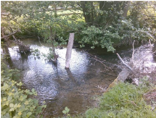
Clôture en mauvais état
