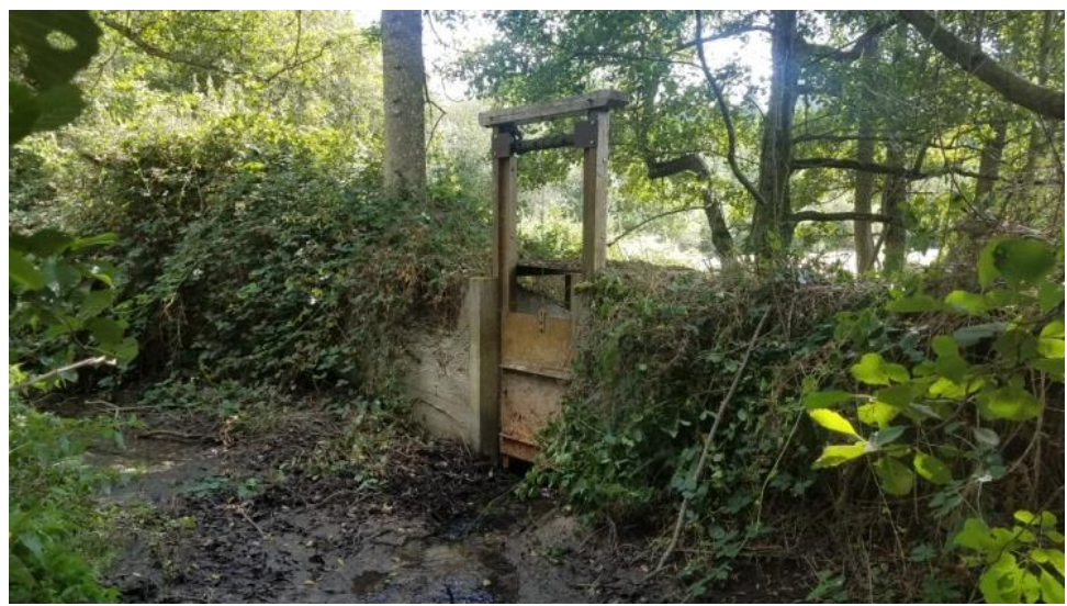
Vanne de décharge sur le bief
