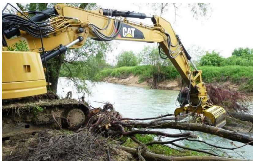
Retrait d'un embâcle à la pelle mécanique (Source : Magnin TP; Fauverney 21)
