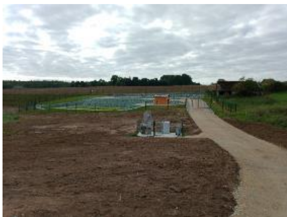
Chantier Grand-Camp - Station d'épuration
