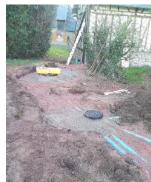
Pose d'une fosse toutes eaux
