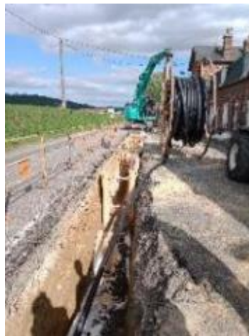
Chantier Serquigny– Hameau de Courcelles
