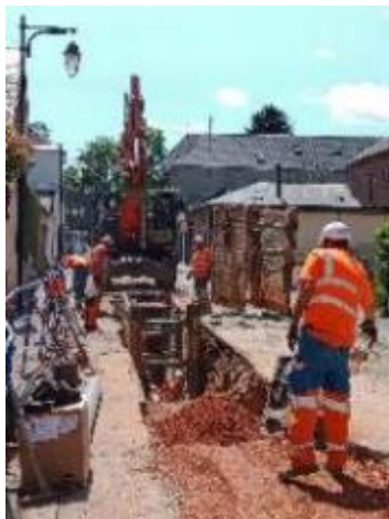
Chantier Bernay – Rue du 11 Novembre
